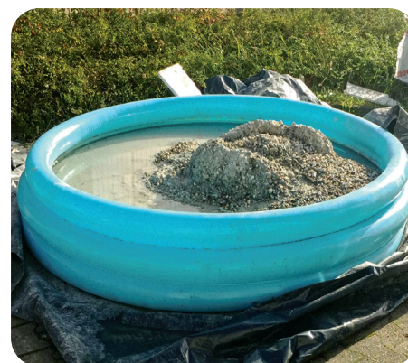
Waschplatz und Zwischenlagerung von Restbeton
