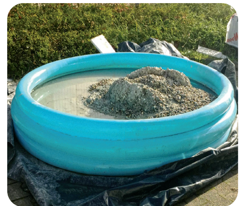
Waschplatz und Zwischenlagerung von Restbeton
